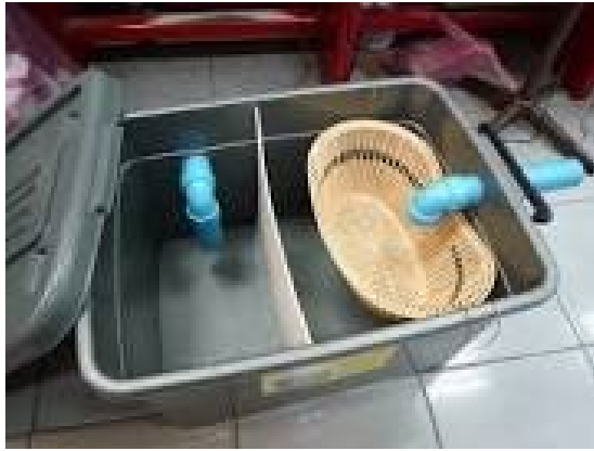
รูปที่ 7 ถังดักไขมันแบบทำเอง
